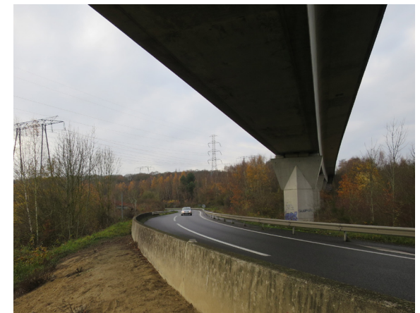
4/ Embranchement A86 (Sous le pont du TGV)
